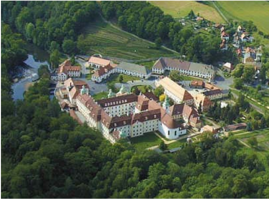
Abb. 39: Sicht auf die Klosteranlage (Quelle: [18])
