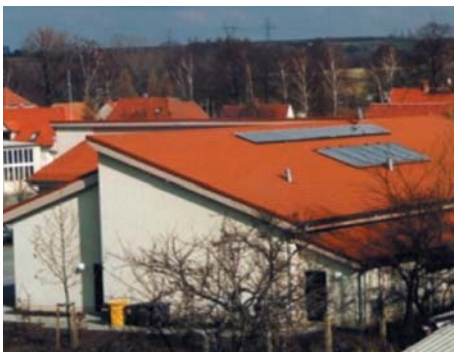
Abb. 17: Feuerwehrgerätehaus in Ostritz (Quelle: [11])
