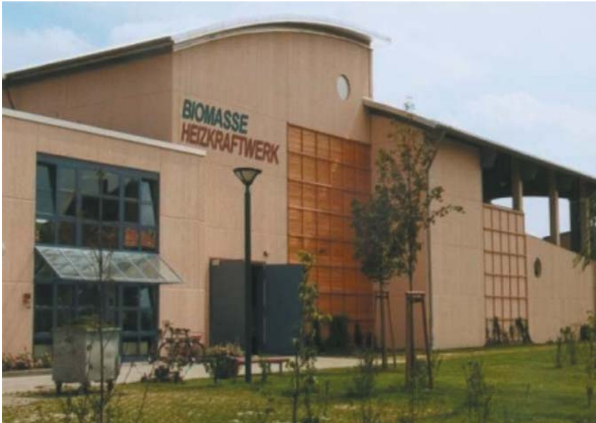
Abb. 31: Biomasse-Heizkraftwerk der Stadt Ostritz (Quelle: [1])
