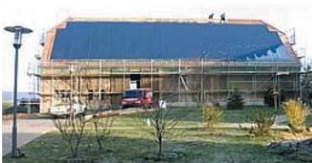
Abb. 16: Sanierung Scheune 2004 (Quelle: [1])
