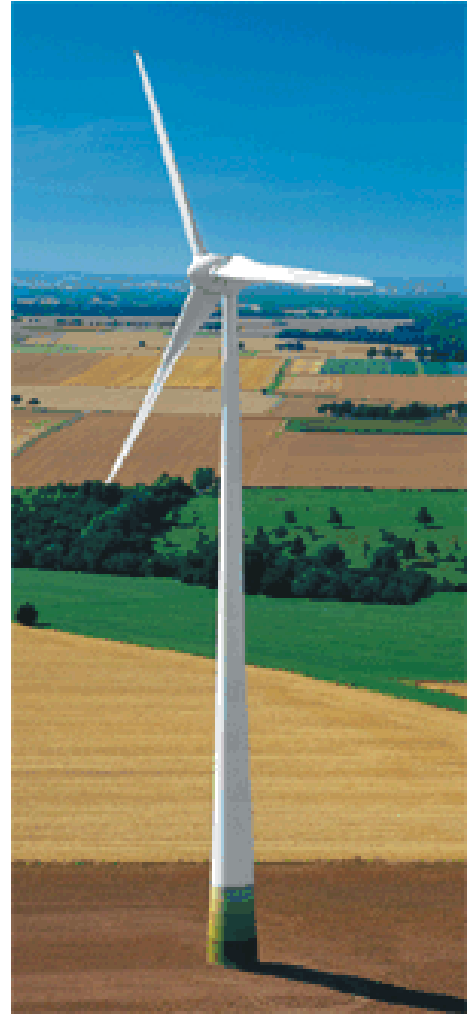
Abb. 19: Enercon 70 (Quelle: www.enercon.de)
