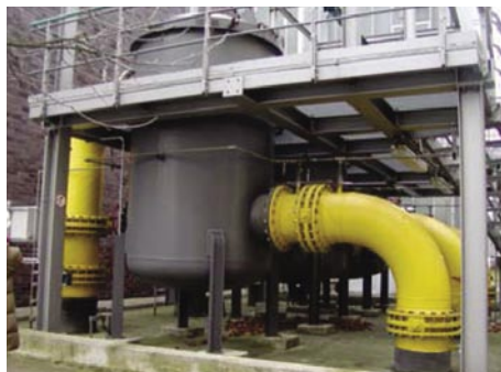
Abb. 22 Verdichterstation Quelle: Eigenes Foto
