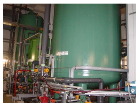
Abb. 42 Aktivkohlefilter für Wassereinigung Quelle: eigenes Foto
