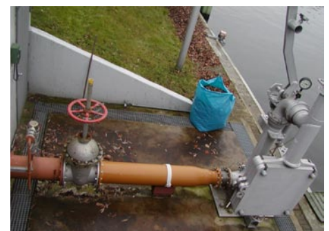
Abb. 27 Schiffsentladungsstelle Die Entladepumpe ist zu sehen. Quelle: Eigenes Foto
