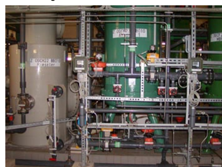
Abb. 41 Ionenaustauscher, CO 2 –Rieseler Quelle: eigenes Foto
