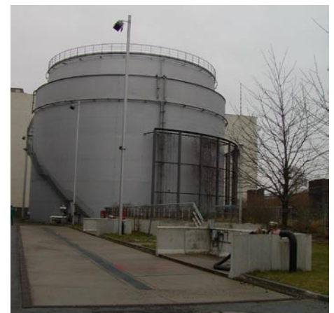
Abb. 26 Heizöltank Die Tankwagenentladungsstelle ist zu sehen. Quelle: Eigenes Foto
