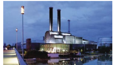
Abb. 17 Heizkraftwerk Mitte Quelle: BEWAG
