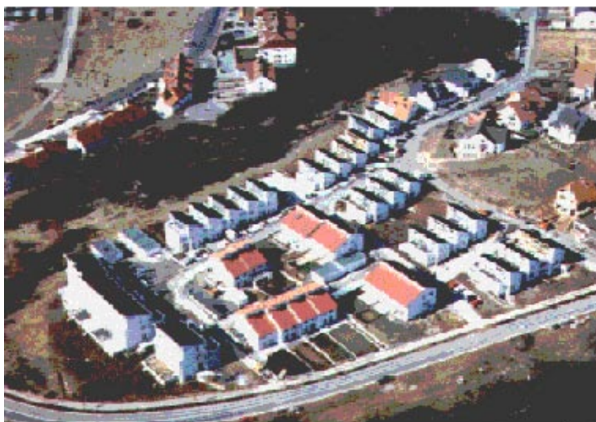
Abb. 31 Luftbild Niedrigenergiesiedlung Diestelweg Quelle: IWU: „Niedrigenergiesiedlung Diestelweg“ in Niederhausen, Darmstadt 1994
