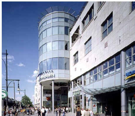
Abb. 2 Kesselanlage Schönhauser Allee- Arcaden, Schönhauser Allee 75 Die Anlage besteht aus einem Brennwertkessel (1.600 kW) der Firma Buderus. Sie ist auf die Verfeuerung von Erdgas mit Gasgebläsebrennern der Firma Riello ausgelegt. Die Kesselanlage wurde in der Dachheizzentrale im 5. Obergeschoss der Schönhauser Allee-Arcaden errichtet und versorgt den Gebäudekomplex mit Wärme zur Raumheizung und Lüftung. Quelle: BewagWärme - Optimale Versorgung direkt vor Ort, Feb. 2002
